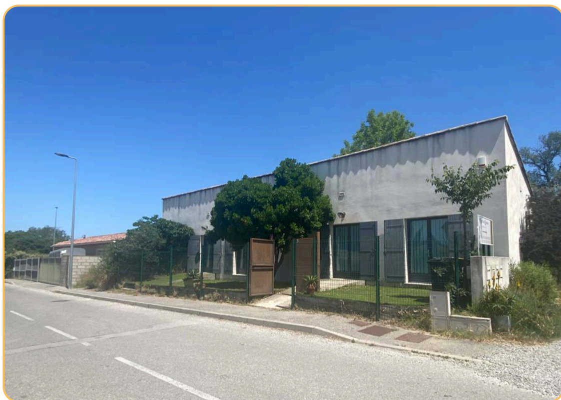
Les nouveaux locaux de la CPTS situés 3 Avenue des Joncades Basses à Saint Rémy de Provence
